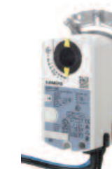
Sobni kontroler Codis C35 i motorni pogon Siemens GxB181.1E/BA
